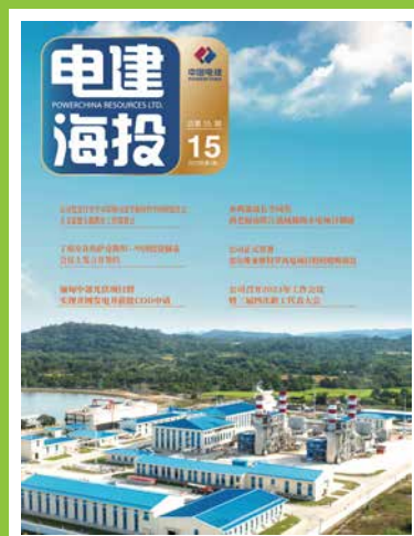
▲ 缅甸皎漂燃气电站项目
